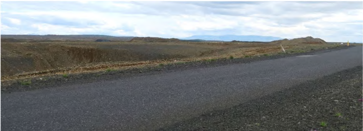
MYND 4.9 Útsýni í austur að efnistökusvæðinu í Rauðamel. Séð frá aðkomuvegi sem tengist Grindavíkurvegi. Efnistökusvæðið er grafið niður í melinn og því nokkrir efnishaugar einu ummerkin sem sjást. Þessu efni verður mokað aftur niður í gryfjuna sem hefur myndast og yfirborðið þannig jafnað.
