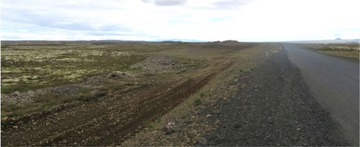
MYND 4.8 Útsýni í austur að efnistökusvæðinu í Rauðamel. Séð frá aðkomuvegi sem tengist Grindavíkurvegi. Efnistökusvæðið er grafið niður í melinn og því nokkrir efnishaugar einu ummerkin sem sjást. Þessu efni verður mokað aftur niður í gryfjuna sem hefur myndast og yfirborðið þannig jafnað.
